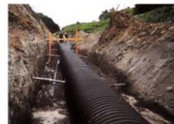
産業廃棄物最終処分場建設工事(長野県)
