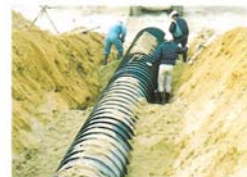
埋立地内雨水排水工事(兵庫県)
