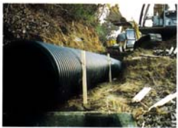
ゴルフ場排水管改修工事(千葉県)
