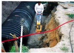
道路維持工事(広島県)
