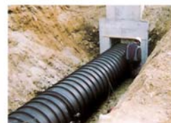
埋立地内雨水排水工事(兵庫県)
