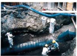
国道改良工事(鹿児島県)
